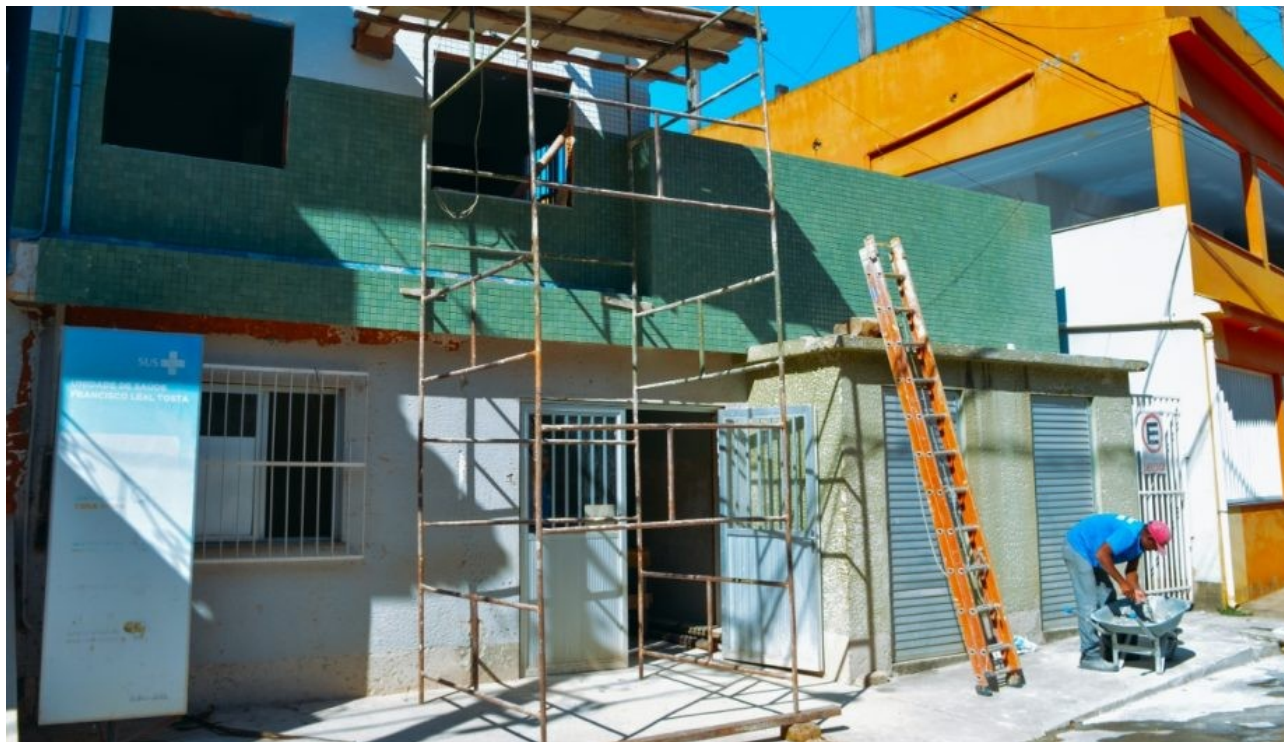
Estão sendo realizadas intervenções estruturais, elétricas e hidrossanitárias Foto: Márcia Leal/PMCI
