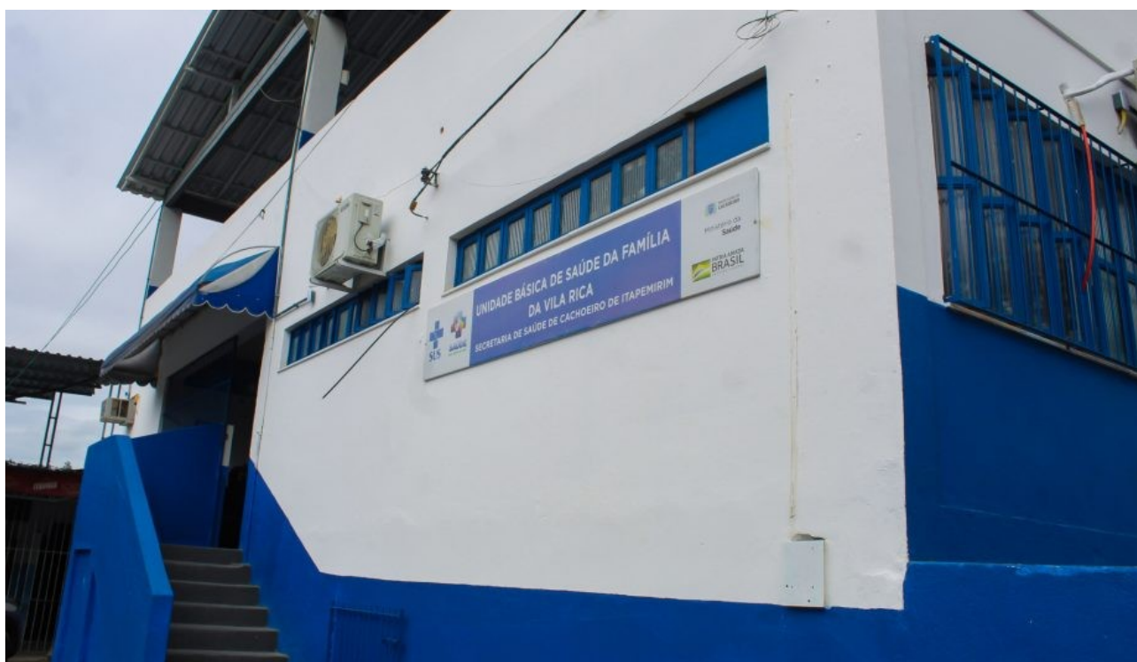
Edifício recebeu diversas melhorias em sua estrutura Foto: Patricia Pim/PMCI
