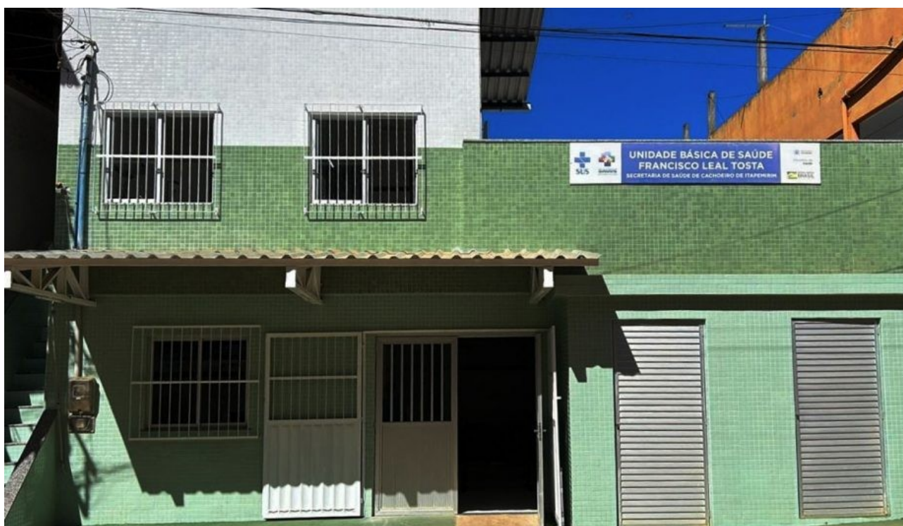
Fachada e ambientes internos foram reformulados para melhorar atendimento aos moradores Foto: Márcia Leal/PMCI
